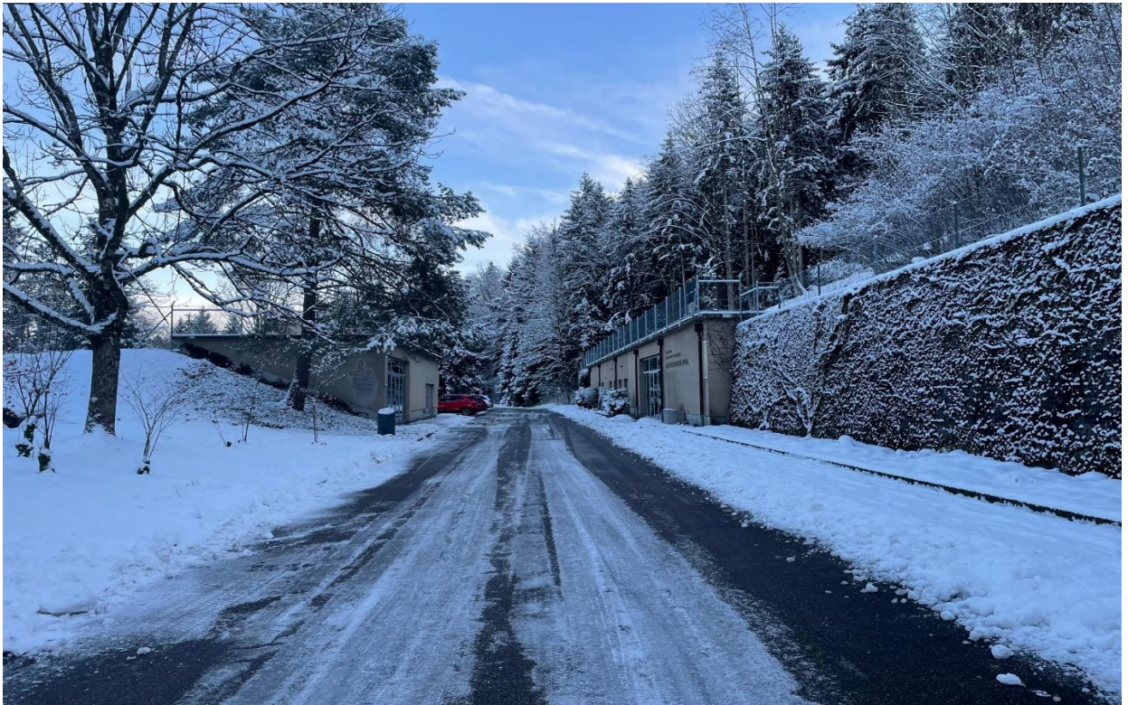
Filter- und Betriebsgebäude, Seewasserwerk Appital
