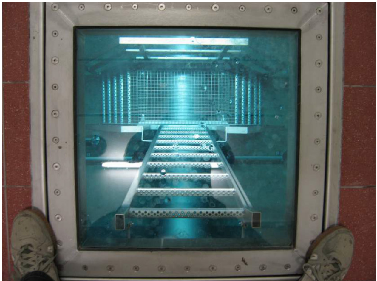
Bodenfenster Ozonkontaktkammer im Seewasserwerk Appital, Au
